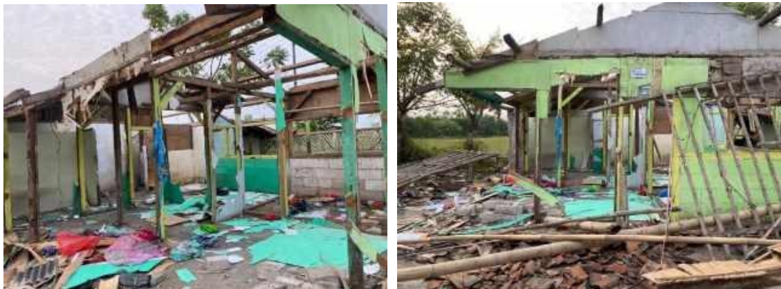
Gambar 3. Bongkar Bangunan Existing
