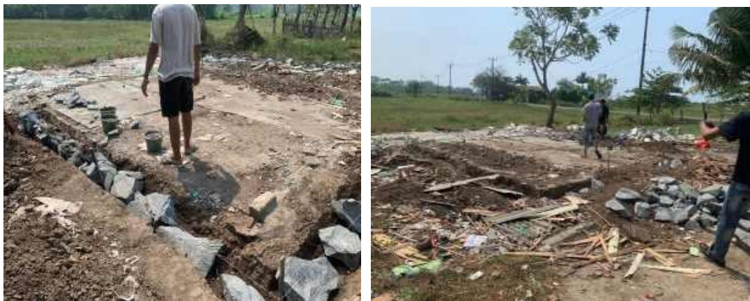
Gambar 5. Galian Pondasi dan Pemasangan Pondasi Batu Kali
